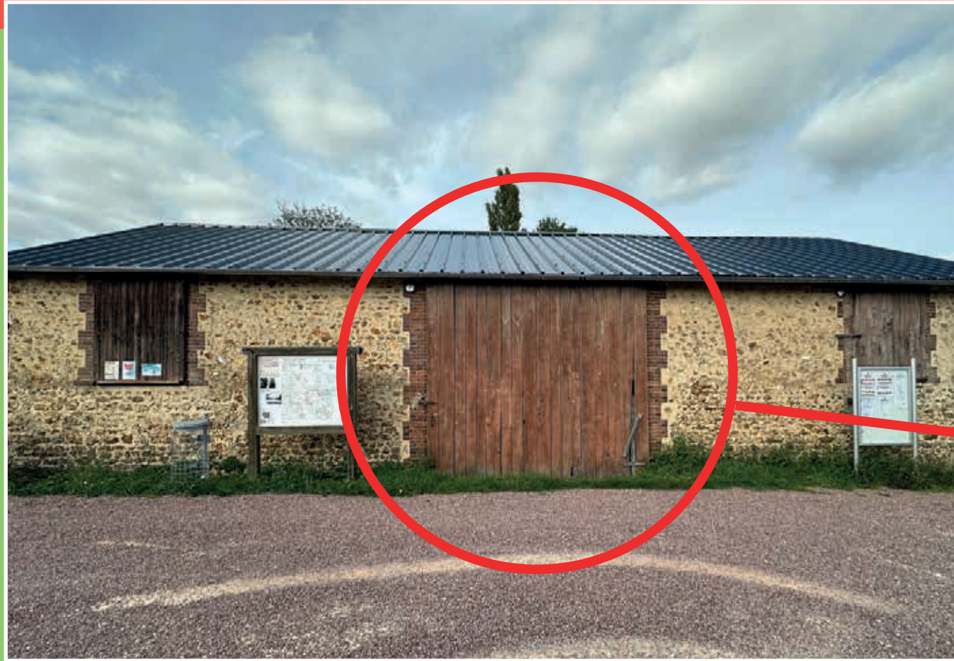
Remplacement de la porte de la grange du Ménéillet
