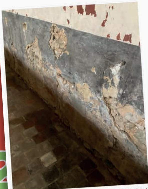
3691 Détachement de l'enduit, mur gouttereau Nord de la nef
